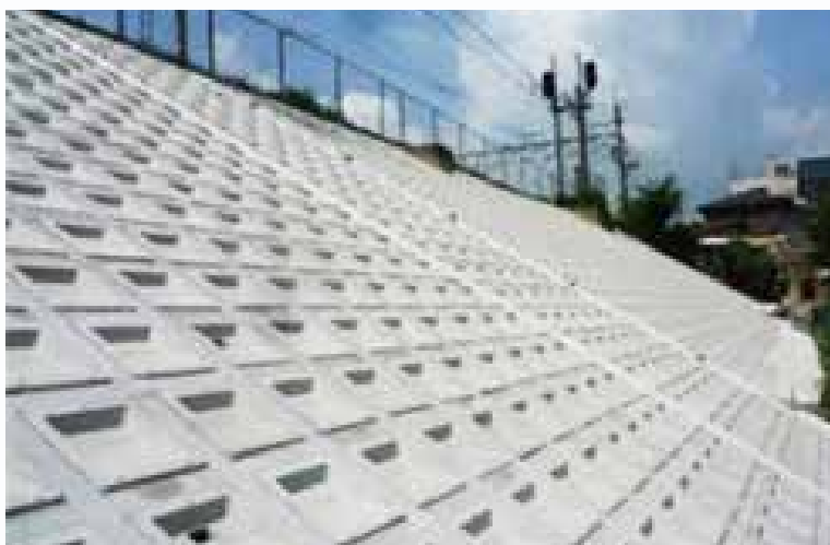
斜面对策後の盛土
